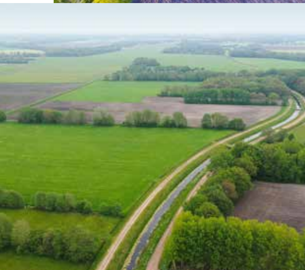
Gekanaliseerde beek in Drenthe
